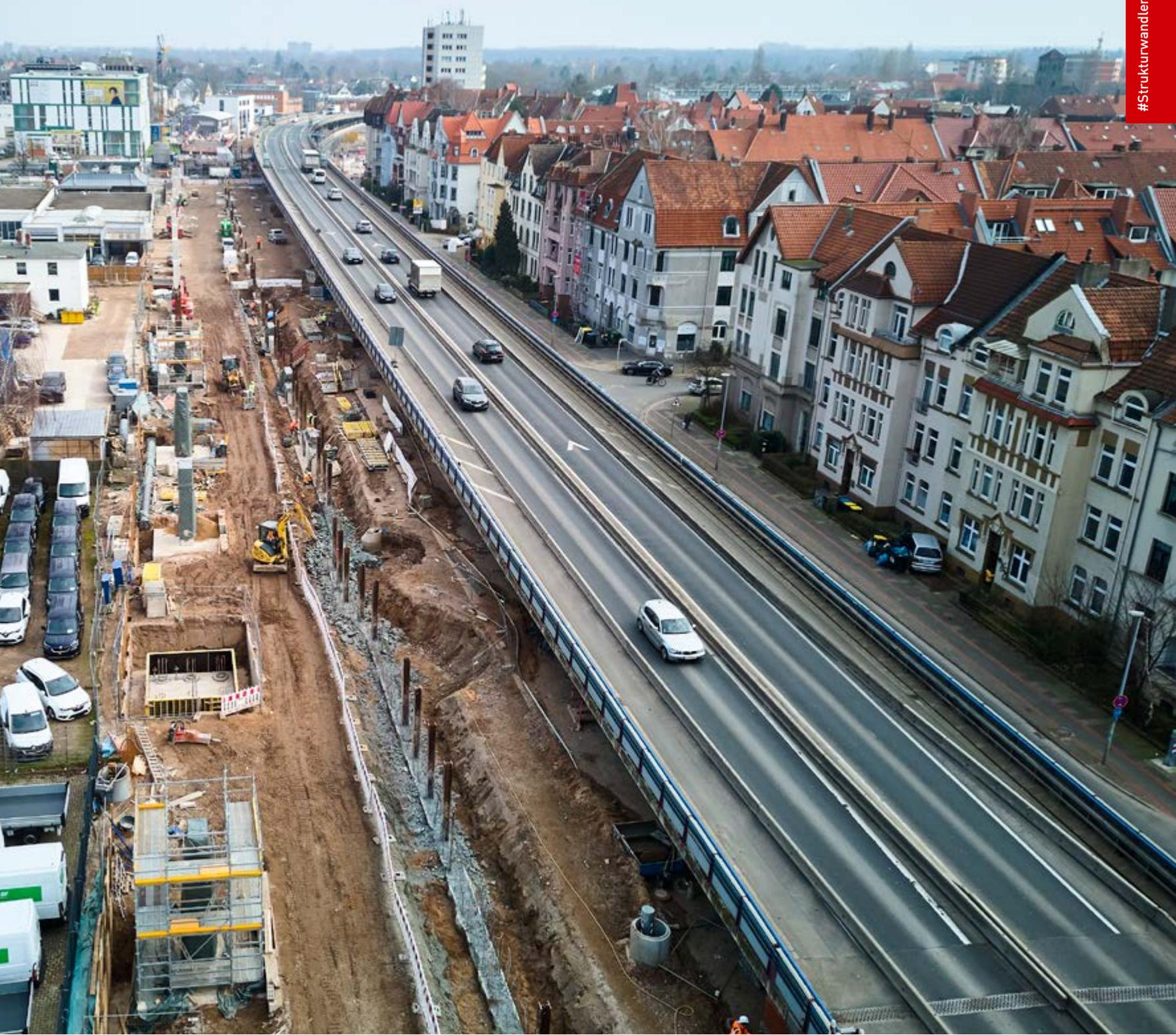
Eine 15 bis 30 Meter tiefe Schlitzwand bildet die Gründung für die Südseite des Behelfsbauwerks.
