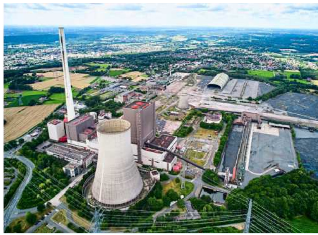
Ehemaliges Kohlekraftwerk Ibbenbüren: In den Außenhüllen von Kühlturm, Kamin und Kesselhaus stecken genügend Schadstoffe, um die ganze Stadt zu verseuchen
