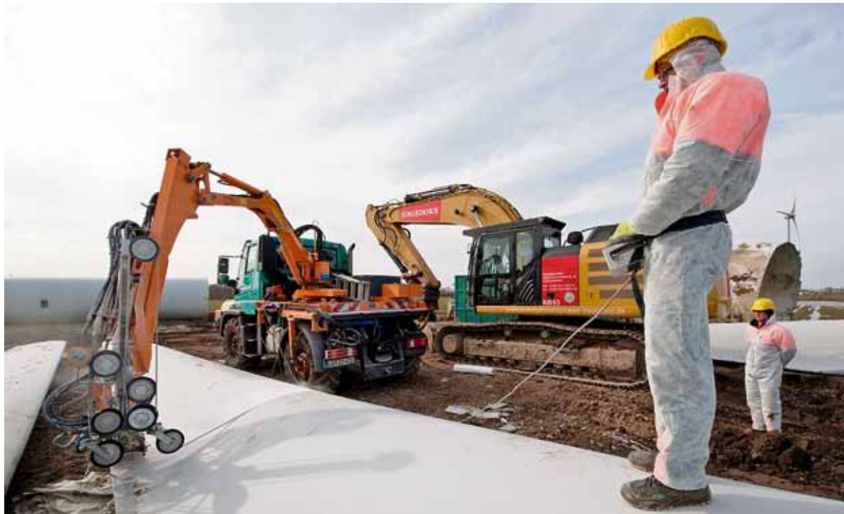
Ausgediente Rotorblätter und Gondeln aus glasfaserverstärkten Kunststoffen werden mittels mobiler Schneidtechnik zerkleinert.
