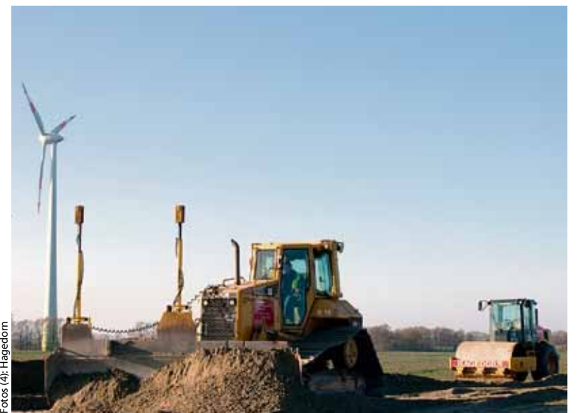
Seit 2012 übernimmt der Betrieb auch Erdarbeiten.
