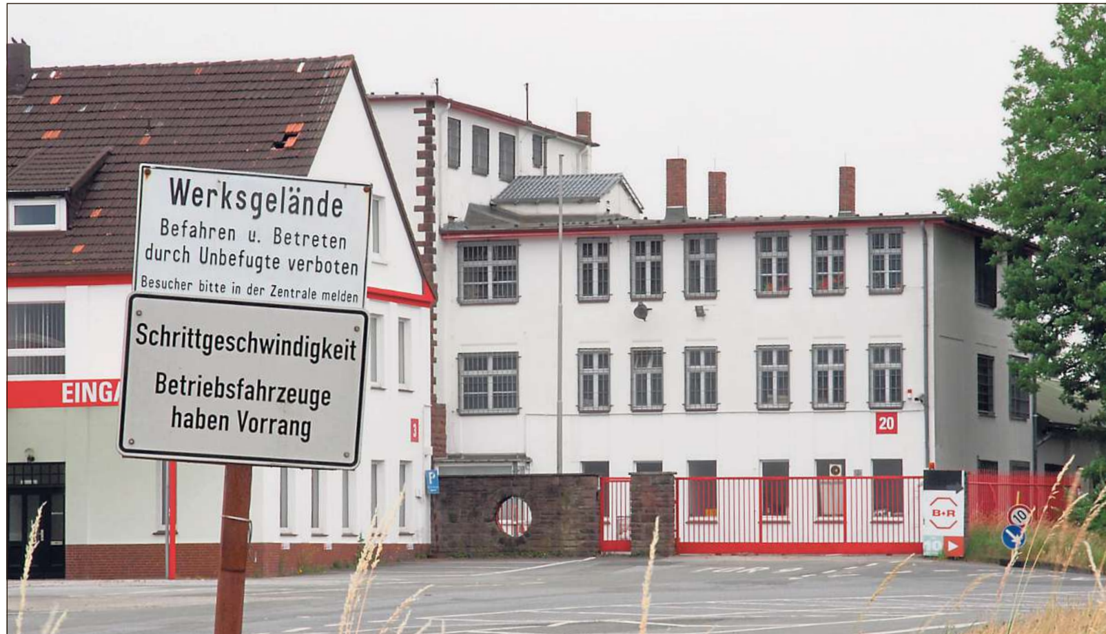
Das Betriebsgelände der früheren Firma Brüggershemke und Reinkemeier liegt an der Berliner Straße neben der Strecke der Teutoburger Waldseisenbahn. Dazu gehört auch das frühere Bundeswehr-Depot (Mitte). Ein Teil der Flächen ist noch vermietet. Bilder: Dinkels (3), Steinecke
