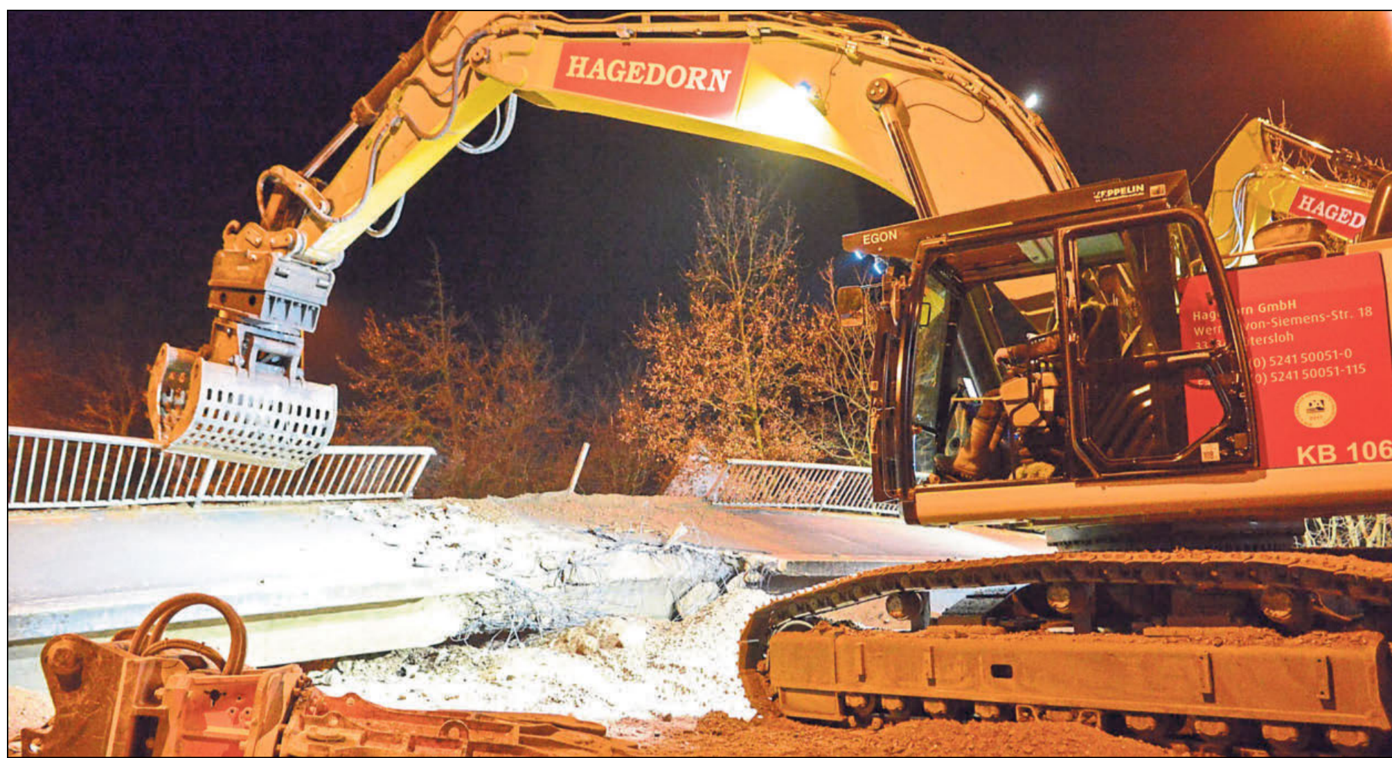
Um kurz nach 21 Uhr beginnen am Samstagabend die Abbrucharbeiten, um 21.26 Uhr liegt das einsturzgefährdete Mittelstück am Boden.
