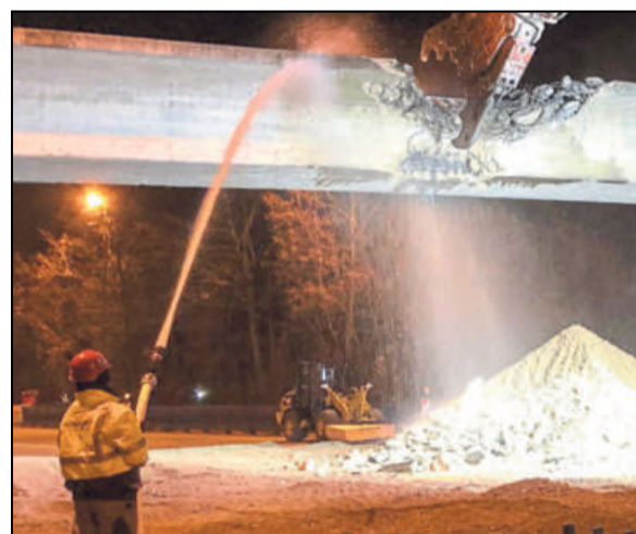
Ein Mitarbeiter bewässert die Brücke, als der Betonschneider am Werk ist. So staubt es weniger.
