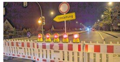
Kein Durchkommen: Die Hauptschlagader durch Gütersloh wurde erstmals seit Bestehen komplett gesperrt.
