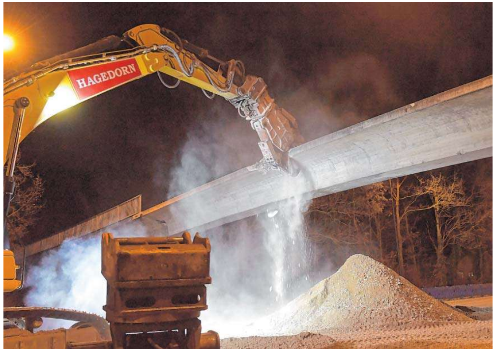
Packte zu: Mit der Kraft eines 100-Tonnen-Baggers zertrümmerte der Pulverisierer den Beton binnen kurzer Zeit.
