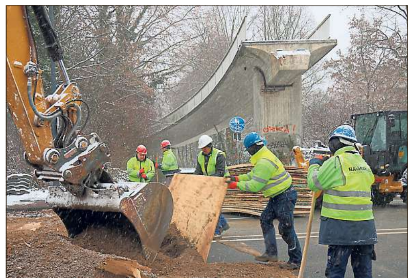
Am Sonntagmorgen wurde der den Asphalt schützende Kies ebenso abtransportiert wie die Holzplatten. Im Hintergrund die übrig gebliebene Abfahrt zum Paul-Westerfröle-Weg. Bild: Scheffler
