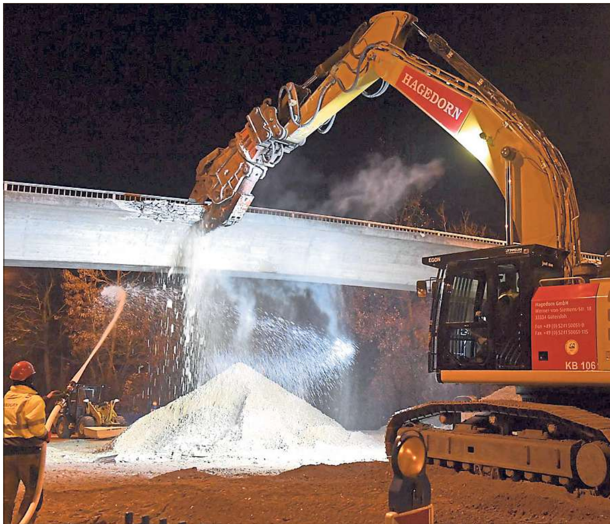
Der Pulverisierer des Abbruchbaggers leistete ganze Arbeit, so dass die Brücke über dem Westring um 21.29 Uhr von den seitlichen Auflagen rutschte. Bilder (5): Dünhöfner
