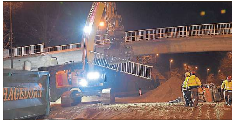
Zwischenakt: Bevor es dem Beton an den Kragen ging, entfernten die Bagger die Gitter der Fußgänger- und Radfahrerbrücke.
