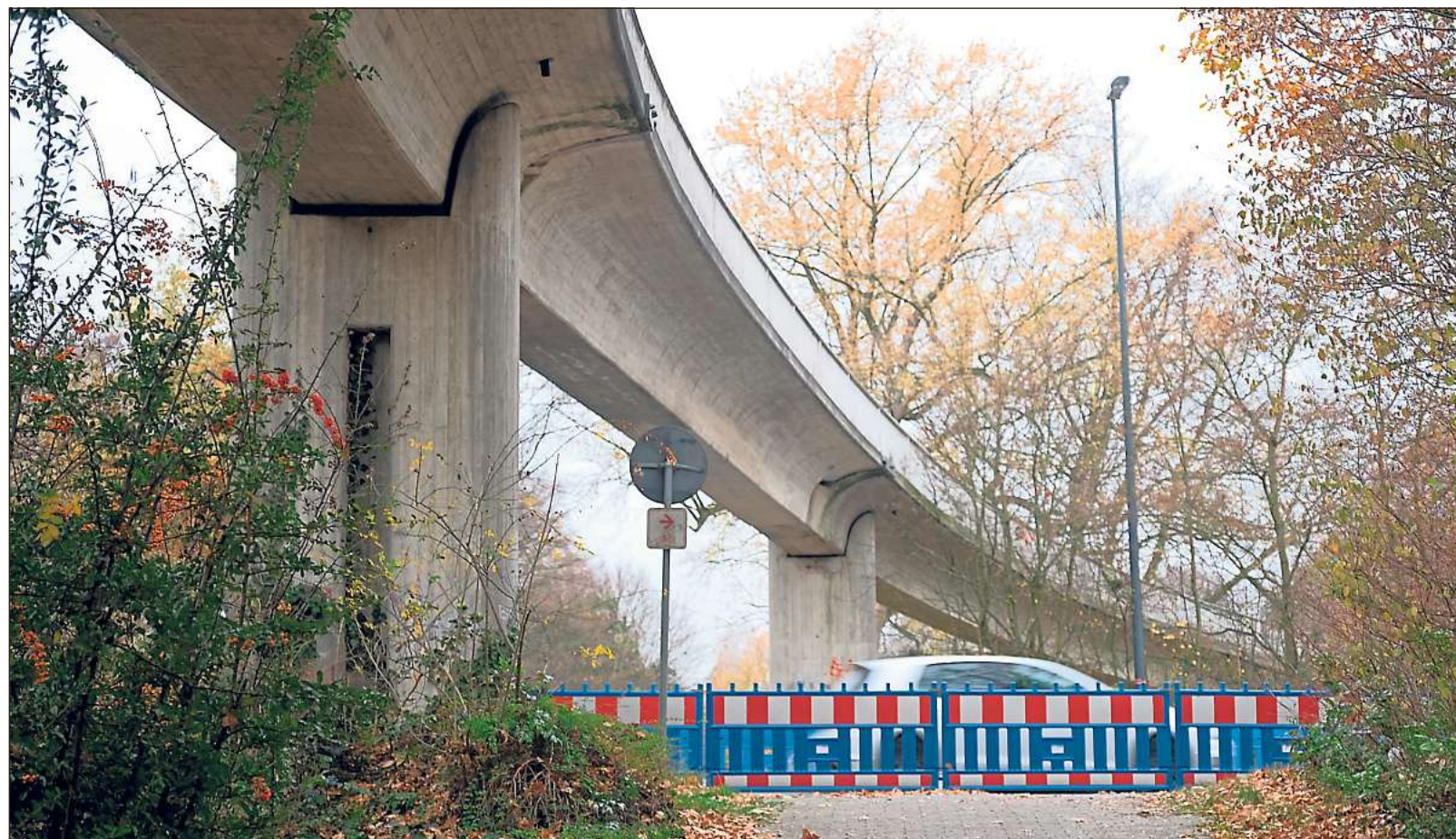
Seit August ist die einsturzgefährdete Fußgängerbrücke über den Westring gesperrt: Am Wochenende wird das mittlere Teilstück des geschwungenen Bauwerks von der Firma Hagedorn von den Pfeilern genommen. Bilder: Dinkels
